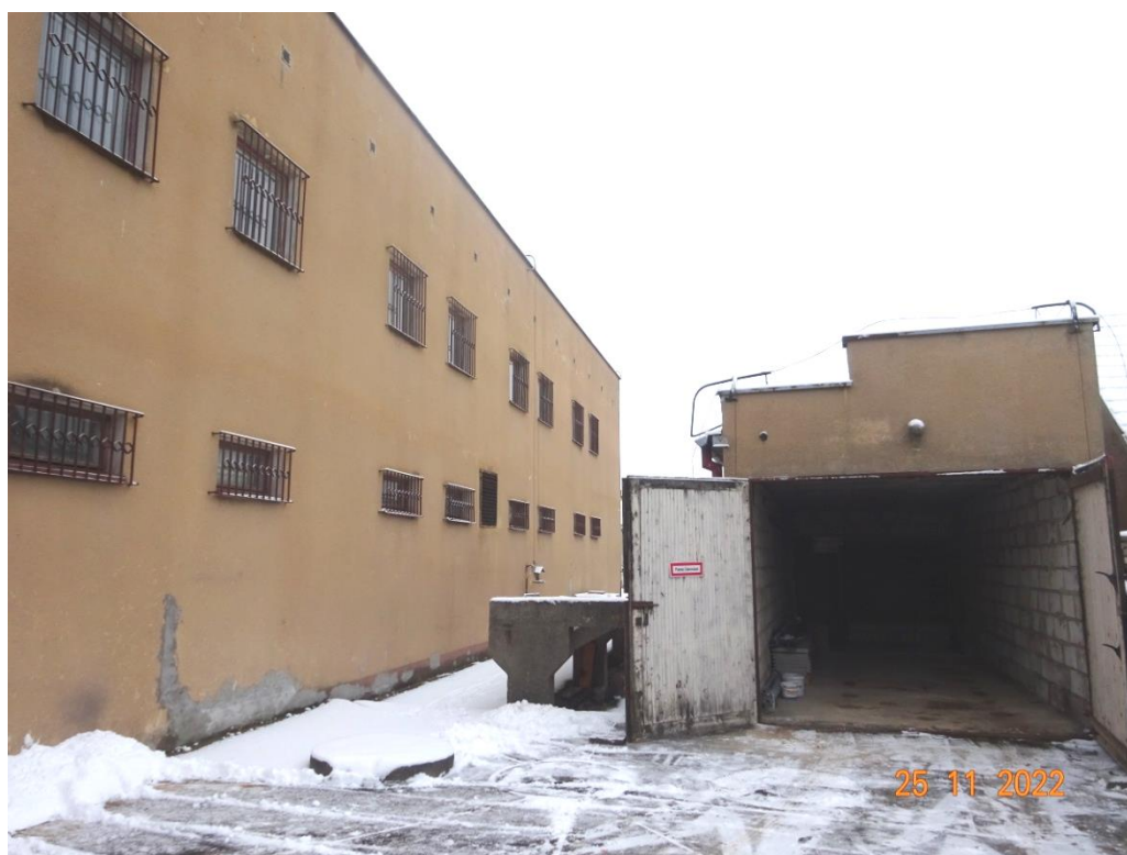
Fot. 6 Południowo -zachodnia ściana budynku A .Po prawej budynek B, Nawierzchnie wokół obu obiektów betonowe. Pomiędzy budynkami żelbet. rampa– do rozbiórki
