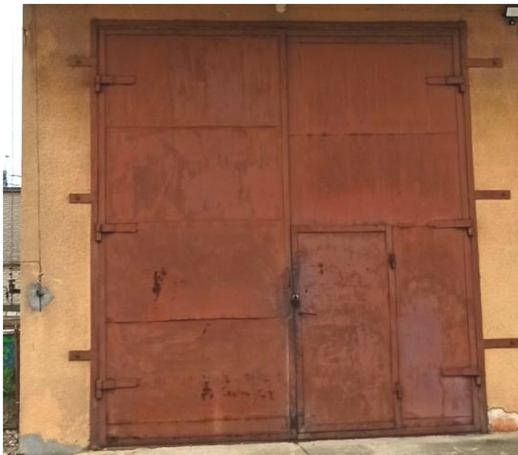
Fot. 6 Wrota stalowe w złym stanie technicznym.
