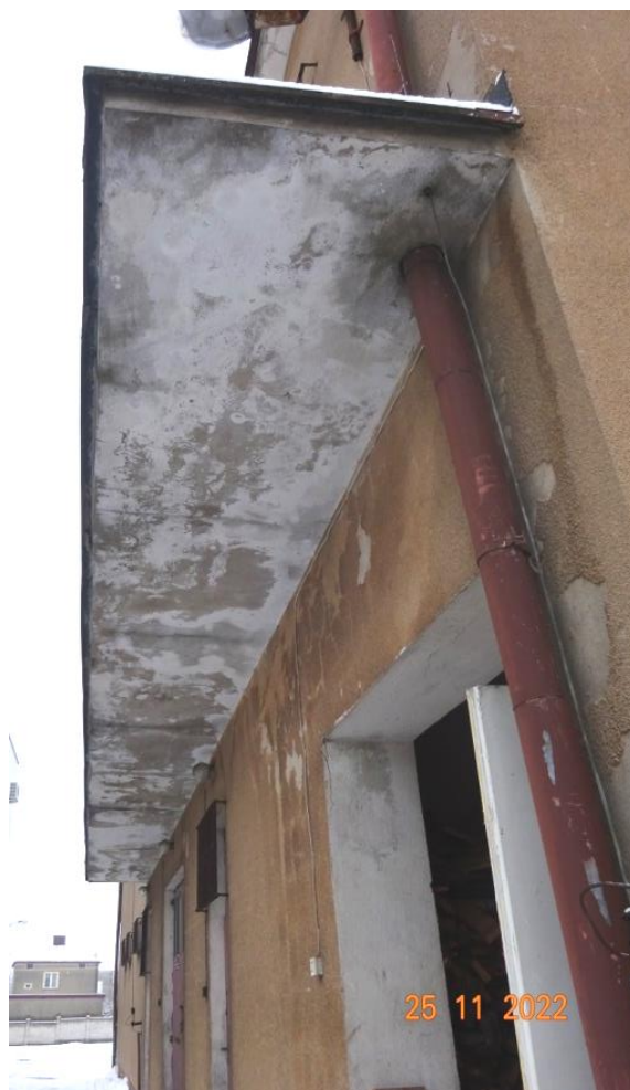
Fot.3 Daszek po stronie zachodnie z uszkodzeniami elewacji
