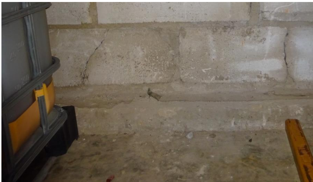
Fot.7 Górny odcinek fundamentu i fragment ściany zewn, z gazobetonu.
