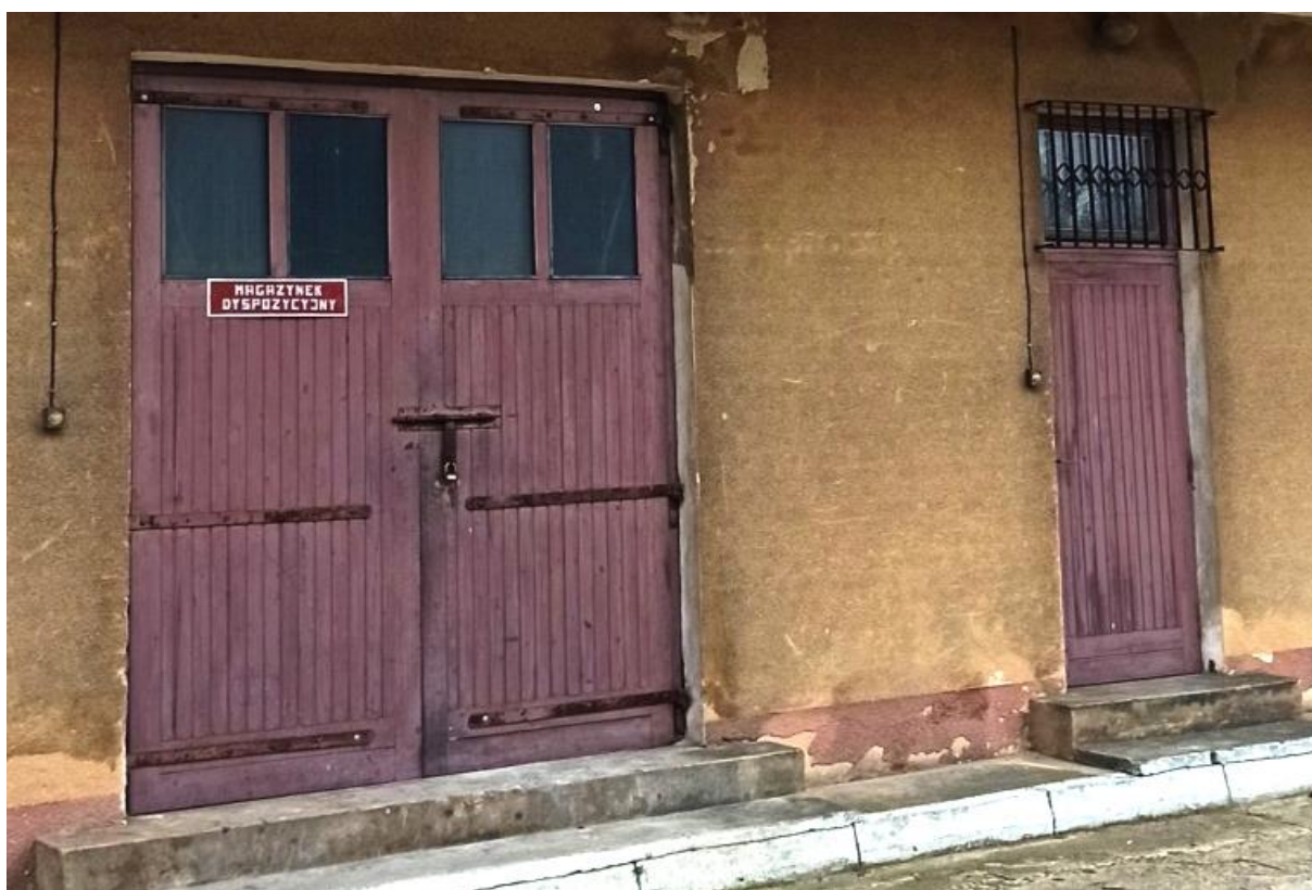
Fot.5 Uszkodzona stolarka drzwiowa przez korozję biologiczną
