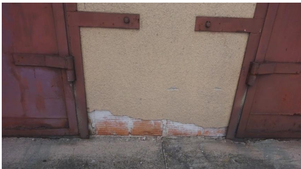
Fot.2 Uszkodzony tynk i cegła muru w strefie cokołowej
