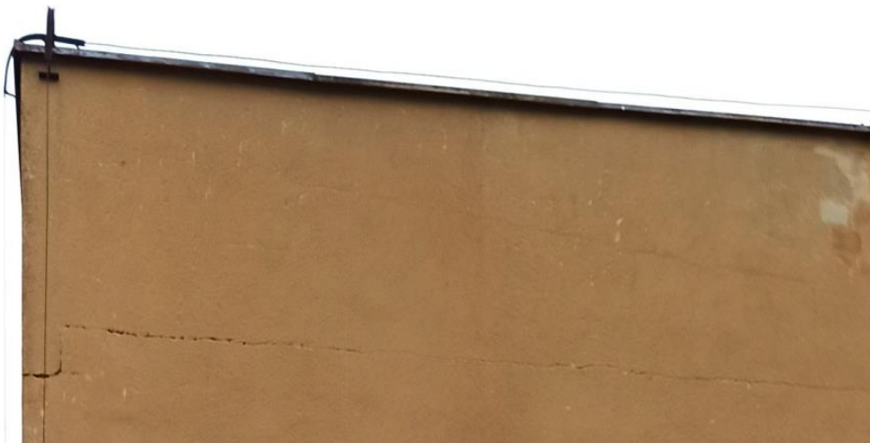
Fot.1 Podłużne i skośne rozwarstwienie tynku południowej ściany szczytowej. Brak połączenia z wieńcem.
