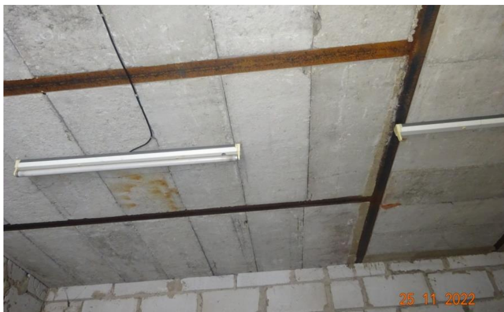
Fot. 9 Strop WPS nad parterem budynku B– garażowo-gospodarczego
