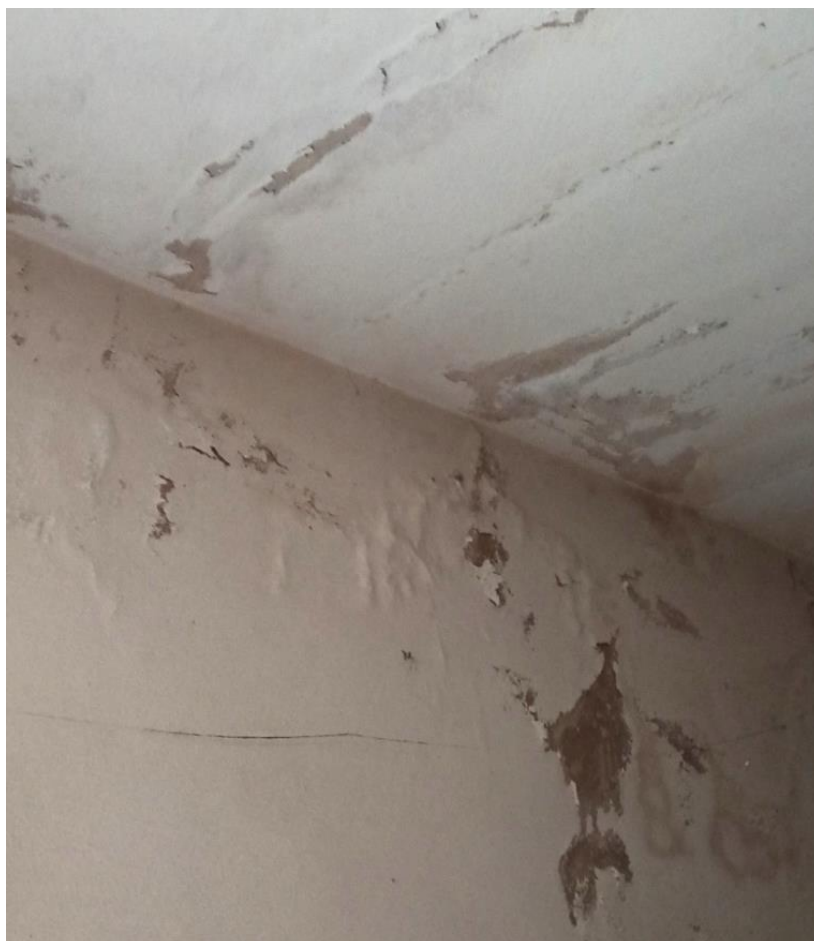
Fot.4 Miejsce na piętrze gdzie występuje hydrolizacja soli budowlanych, a towarzyszy im Grzyb rozkładu pleśniowego (rodzaju Aspergillus )
