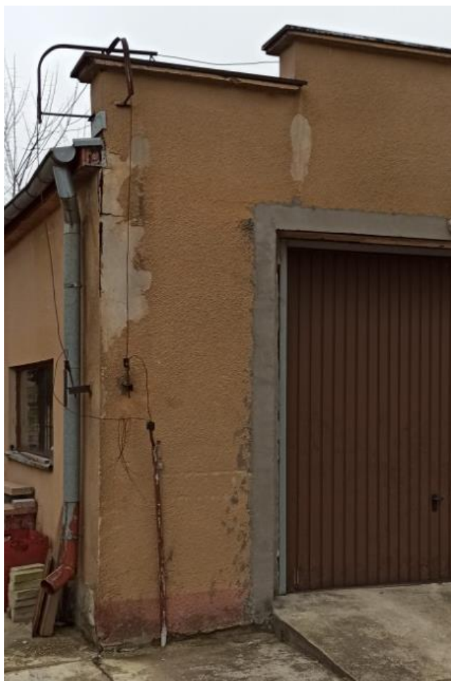
Fot.8 Uszkodzenia ścian konstrukcyjnych a/pęknięcie wylotne muru b/uszkodzenie muru w narożniku budynku B
